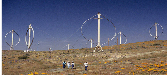
Fotoğraf 2.5. DüŖey eksenli rüzgar türbini (Darrieus tipi) (Url-11)
