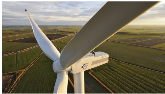
Fotoğraf 2.4. Yatay eksenli rüzgar türbini (Url-10)
