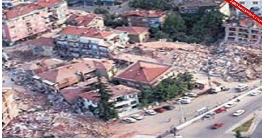
Şekil 1.9. Marmara depreminden Kocaeli ilindeki hasarlara dair bir görünüm (Sabah)
