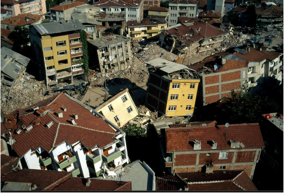
Şekil 1.11. Marmara depreminden Adapazarı ilindeki çarpışma hasarlarına dair bir görünüm (Slingomom)
