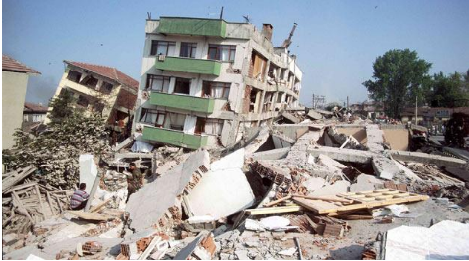
Şekil 1.10. Marmara depreminden Kocaeli ilindeki çarpışma hasarlarına dair bir görünüm (Samsunhaber)
