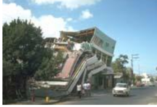
Şekil 1.5. Managua depreminde çarpışmadan kaynaklanan bir hasar örneği (NİSEE e-Library, 2015)
