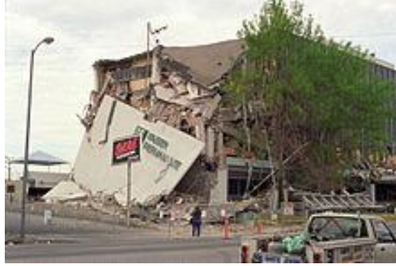
Şekil 1.8. Northridge depremine ait bir görüntü (Wikipedia, 2015)
