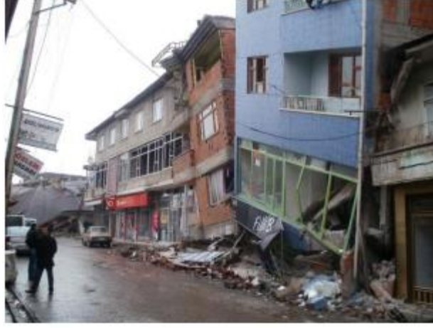
řekil 1.12. Erciř'te arpıřma etkisi ile aęır hasar gren veya gen binalar (nen vd., 2012)
