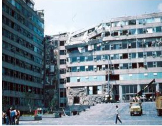
Şekil 1.6. Mexico City depreminde çarpışmadan kaynaklanan hasar örneği (Wikispaces, 2015)
