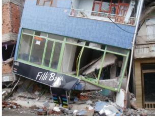
řekil 1.13. Erciř'te arpıřma etkisi ile aęır hasar gren veya gen binalar (nen vd., 2012)
