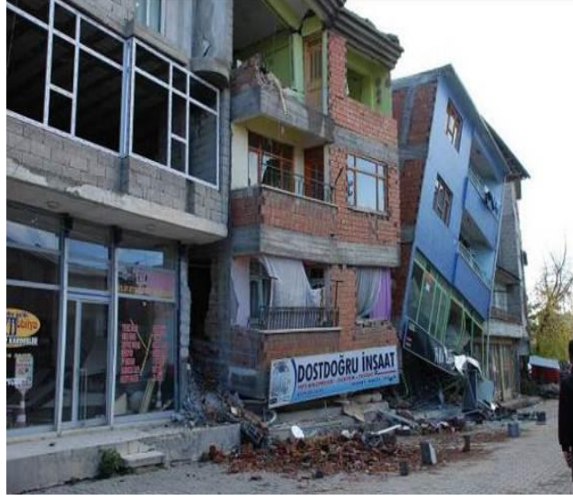
Şekil 1.15. Çarpışma sonucu oluşan hasar (Önen vd., 2012)
