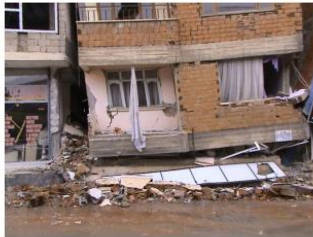
řekil 1.14. Erciř'te arpıřma etkisi ile aęır hasar gren veya gen binalar (nen vd., 2012)
