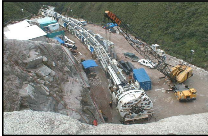
Fotoğraf 2.3 Sert kayada kullanılan bir TBM modeli [7]
