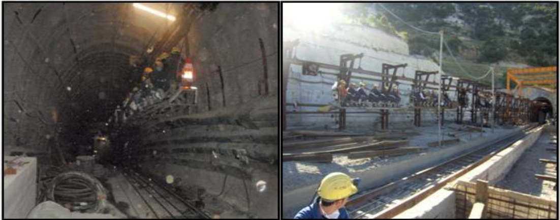
Fotoğraf 4.2 Hazırlık galerilerine elektrikli monoray ile insan nakliyatı
