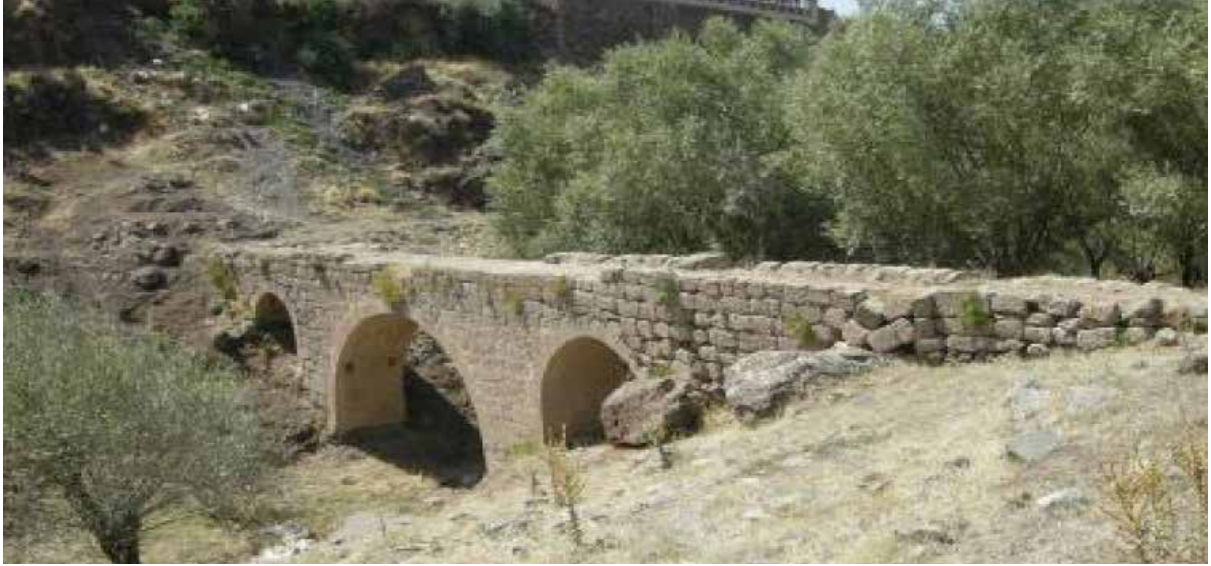
Fotoğraf 112: Yarım Daire Kemerlerden Oluşan, Üç Açıklıklı Su Kemerleri
