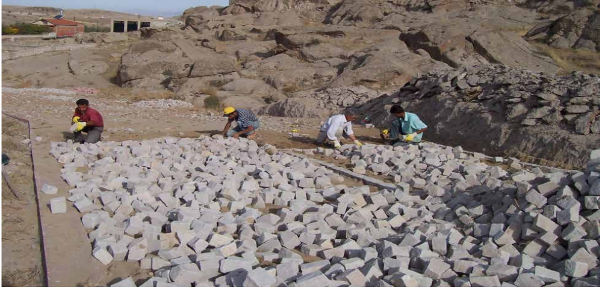
Fotoğraf 21: İlçe Merkezi Yol Çalışması
