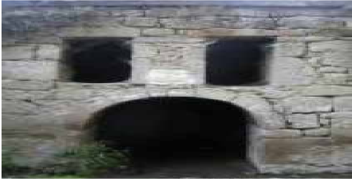
Fotoğraf 115: Tonoz Örtülü Sivri Takviye Kemerli Çamaşırhane
