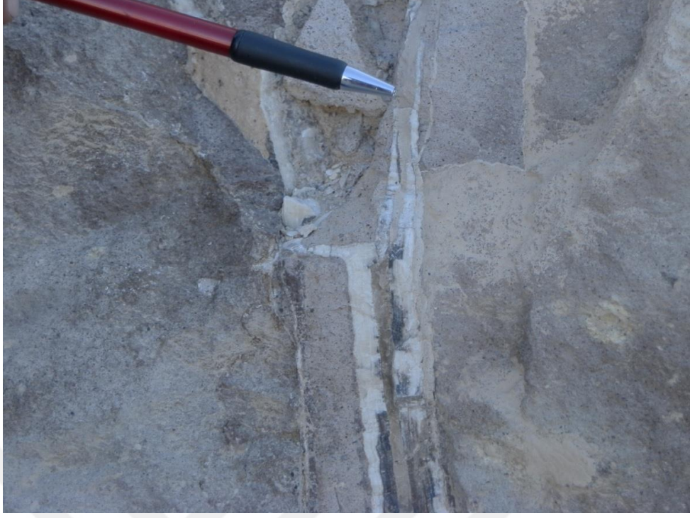
Şekil 5. 2. Havuzlu İgnimbiriti'nde bulunan çatlak dolgusundan bir görünüm
