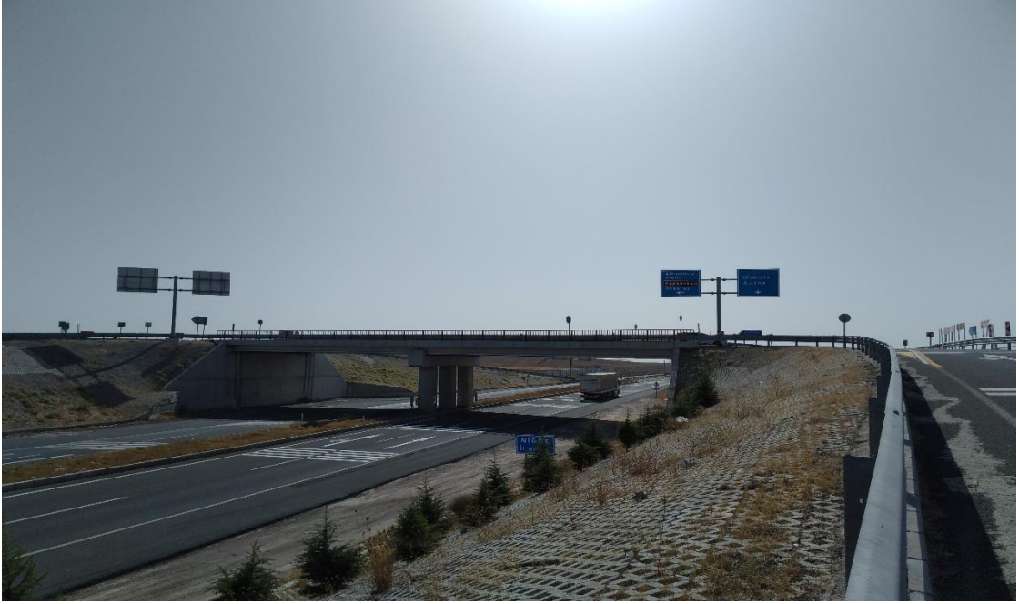
Fotoğraf 5.1. Görüntüleri almak için kamera yerleştirilen köprü.
