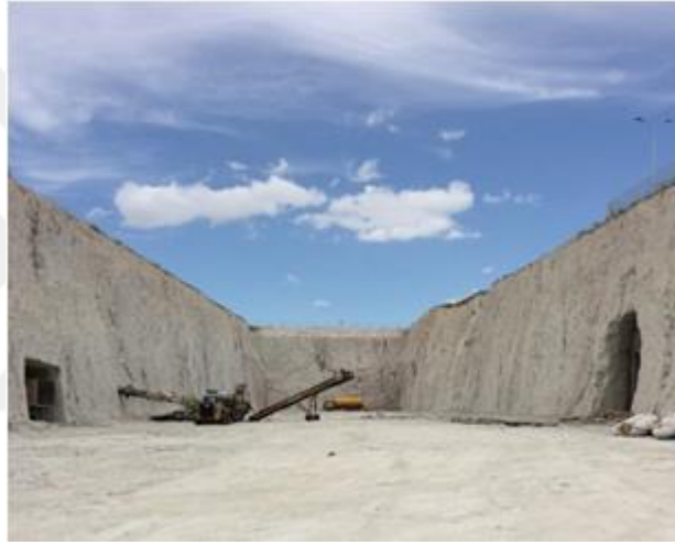
Şekil 3.4. Aktaş soğuk hava deposu görünümü
