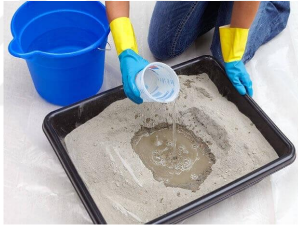
Şekil 2.10. Beton karma suyu
