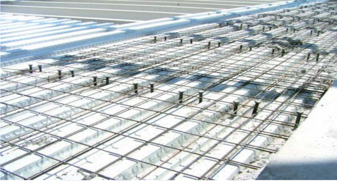
Şekil 2.10. Kompozit döşemede donatı çeliğın kullanımı
