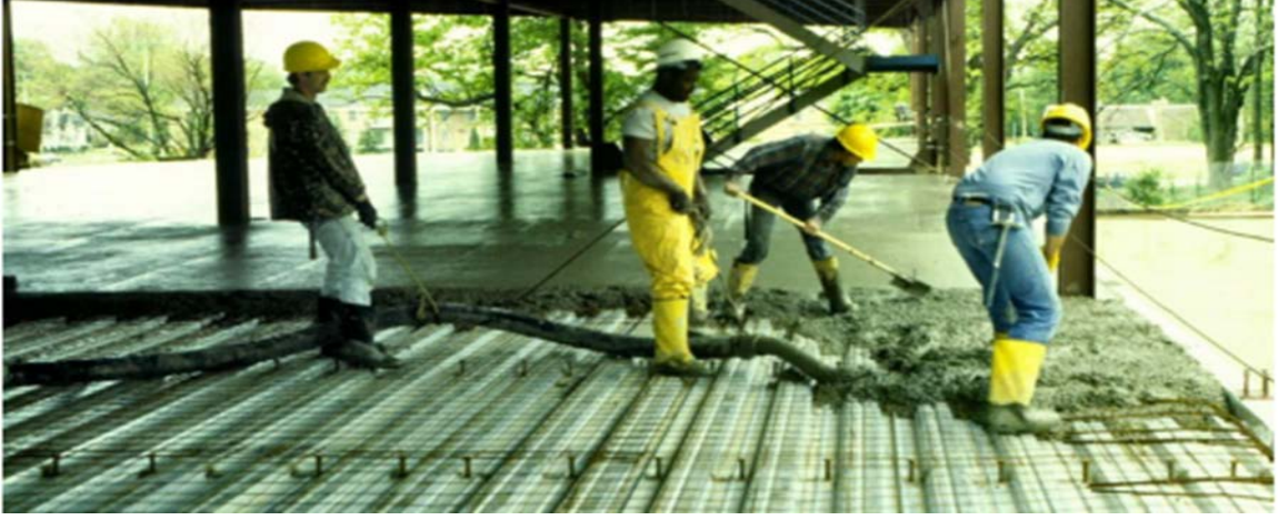
Şekil 2.11. Kompozit döşemede çelik sac üzerine beton dökümü
