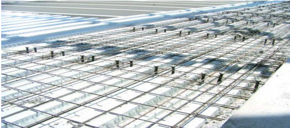
Şekil 2.7. Kayma bağlantısı -kayma kaması-stud çivisi
