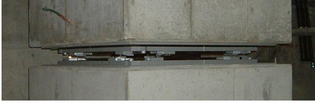
Fotoğraf 4.10. Kolon ortasında sürtünmeli sarkaç sistem uygulaması
