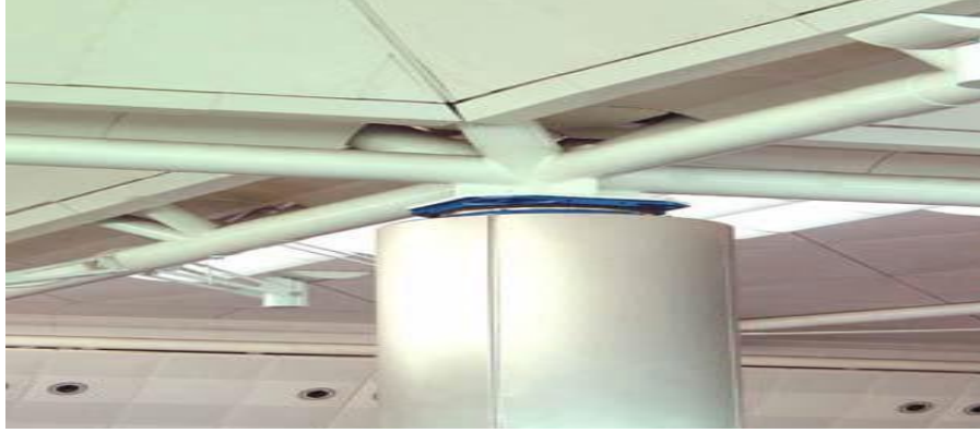
Fotoğraf 4.17. Atatürk Havalimanında kullanılan bir sürtülmeli sarkaç mesnet
