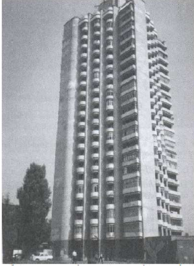
Şekil 2.6. AA-YFC betonu ile inşa edilmiş bina (Shi ve ark., 2006 b).
