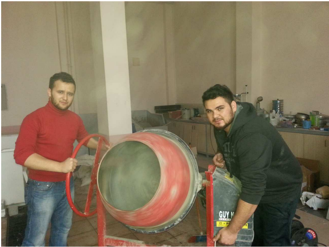
Fotoğraf 3.3. Taze betonun hazırlanması
