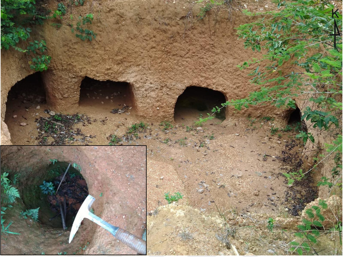
Fotoğraf 1.1. Bölgede açılan araştırma kuyuları ve galerilere ait görüntü
