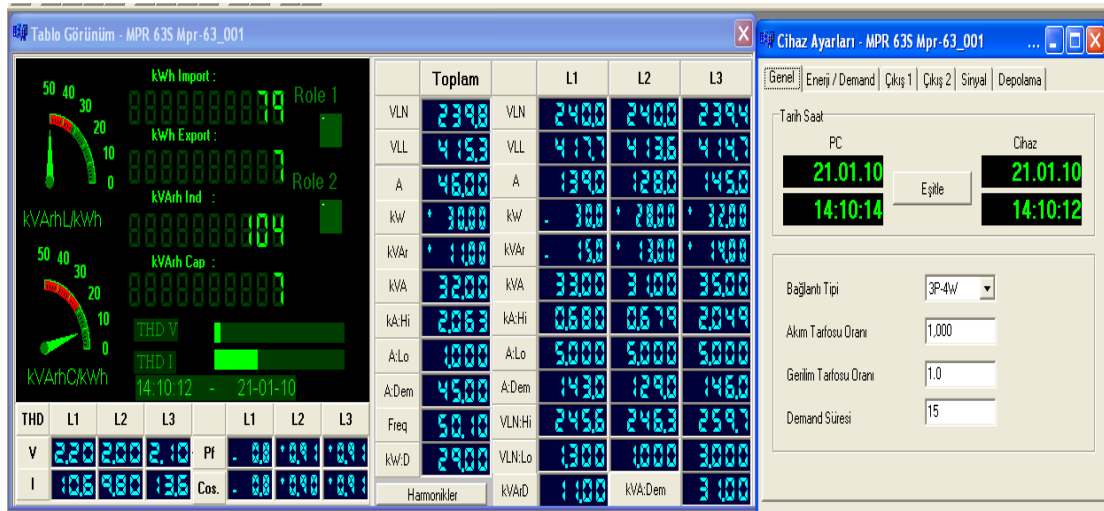
Şekil 4.14 TR-2/10 trafosu ana giriş genel tablo görünümü
