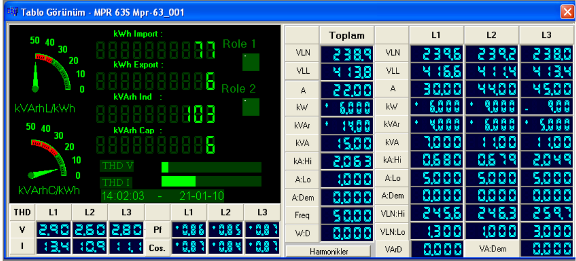
Şekil 4.27 TR-2/10 trafosu 3 nolu çıkış genel tablo görünümü
