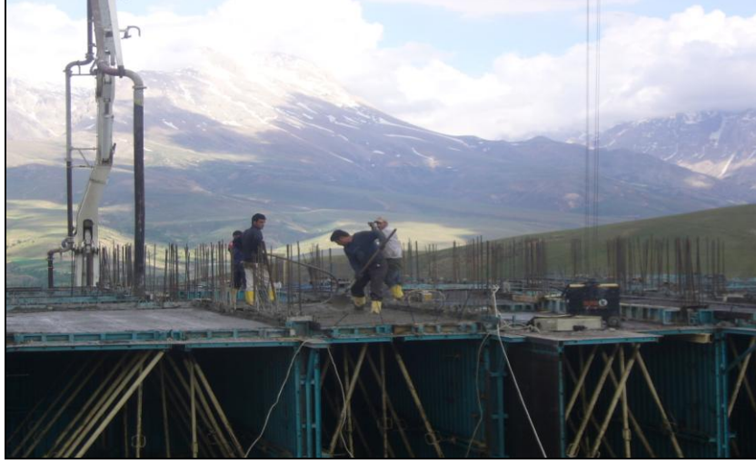
Şekil 2.4. Beton dökümü
