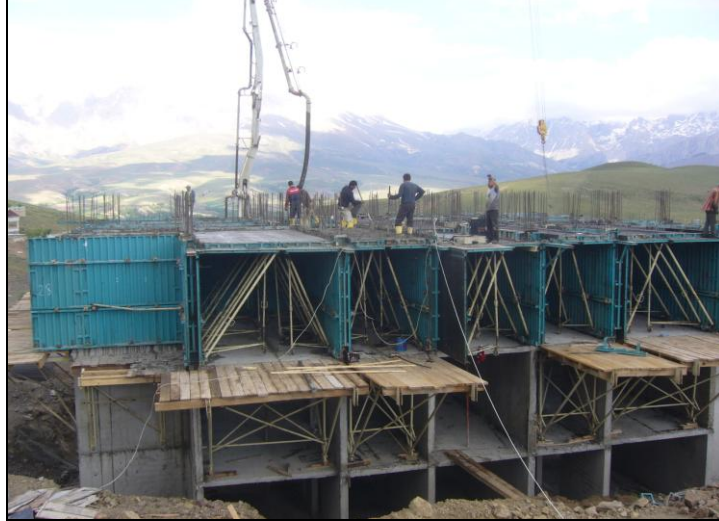
Şekil 2.3. Beton dökümü öncesi hazırlıklar
