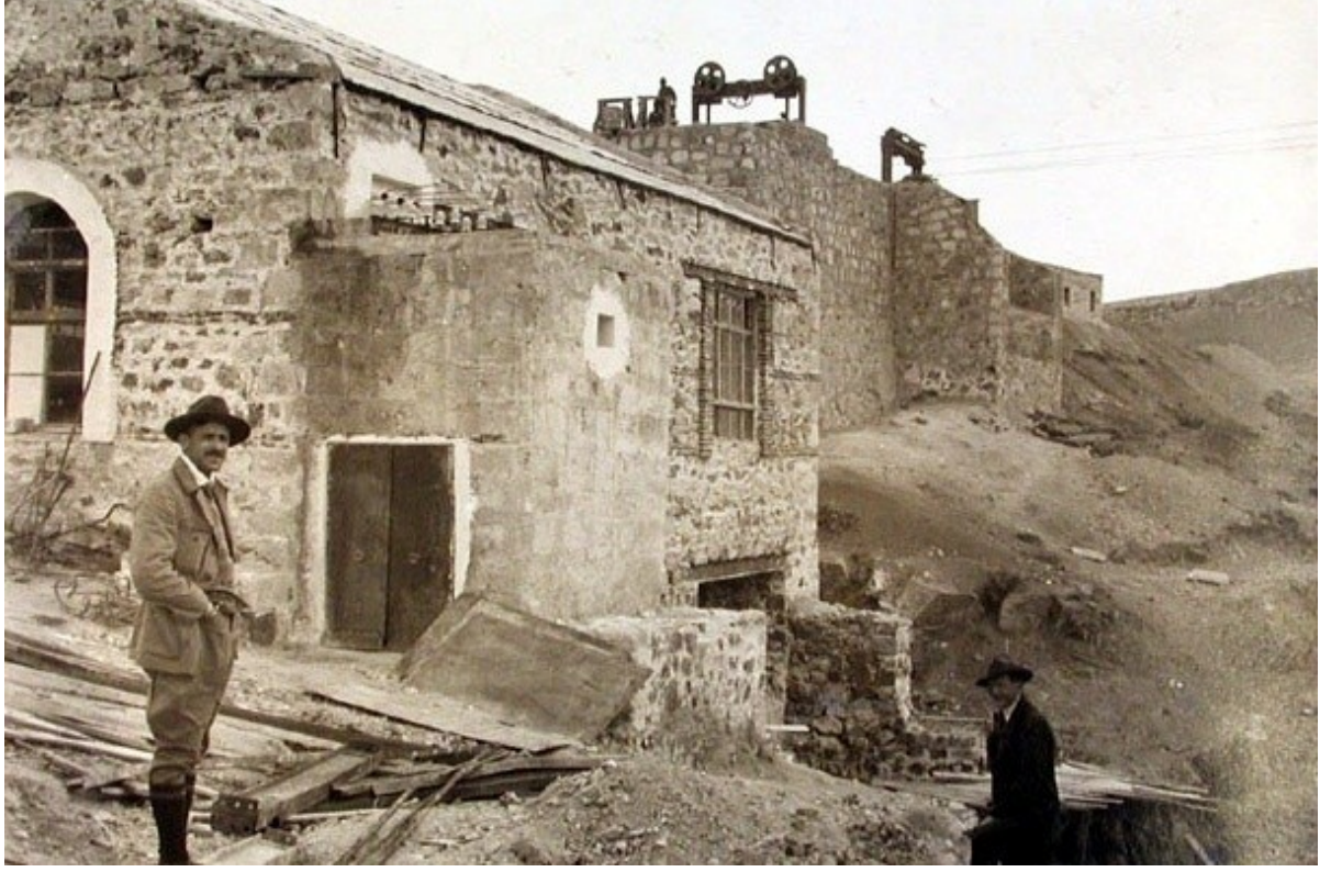
Ek 9: Azmi Milli T.A.Ş.'nin elektrik santrali içi.
