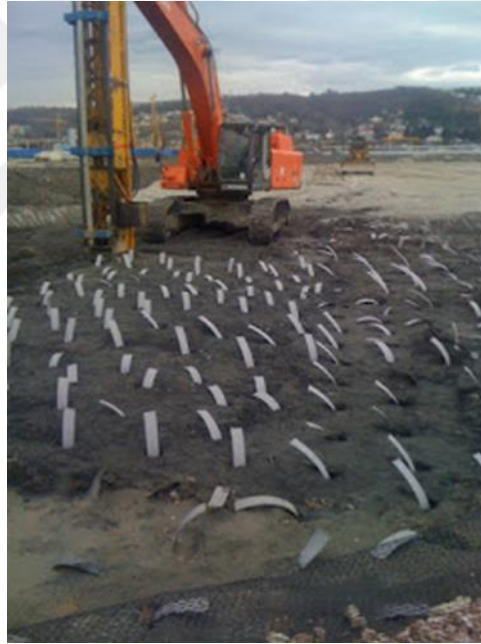
Fotoğraf 1.3. Düşey drenlerin inşası (URL-3, 2019)
