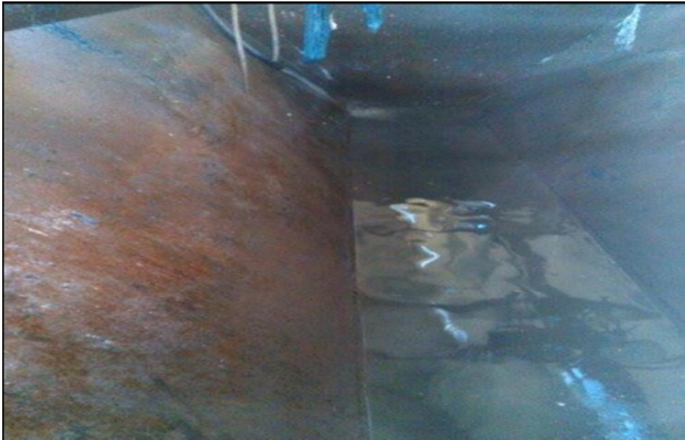
Şekil 2.6. Yıkama havuzunun temiz suyla doldurulması
