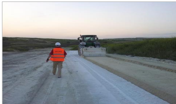
Fotoğraf 3.1. Kireç ile karayolu zemin iyileştirilmesi (Al, 2018)
