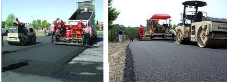
Fotoğraf 3.2. Bitüm ile zemin stabilizasyonu (Aydın, 2018)
