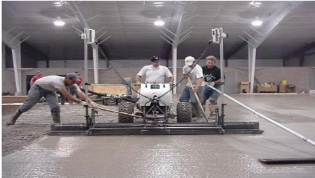
Fotoğraf 3.1. Laserli master kullanarak lifli beton perdahı
