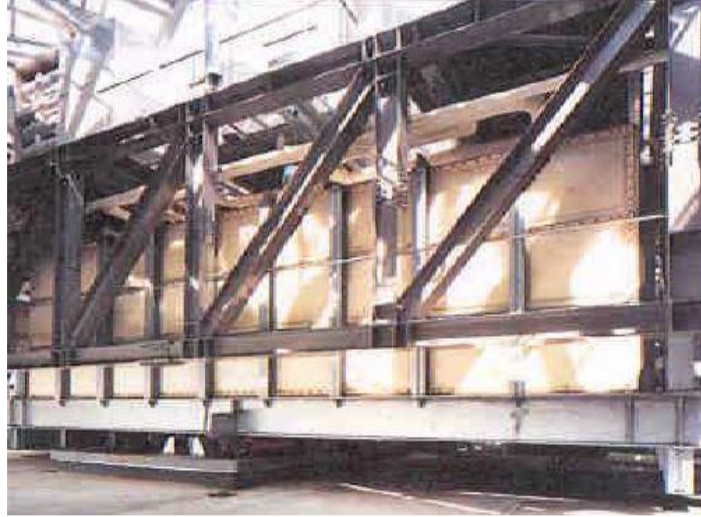
Fotoğraf 6.8. Buz depolama tankı, Crystal Tower (Connor, 2003)
