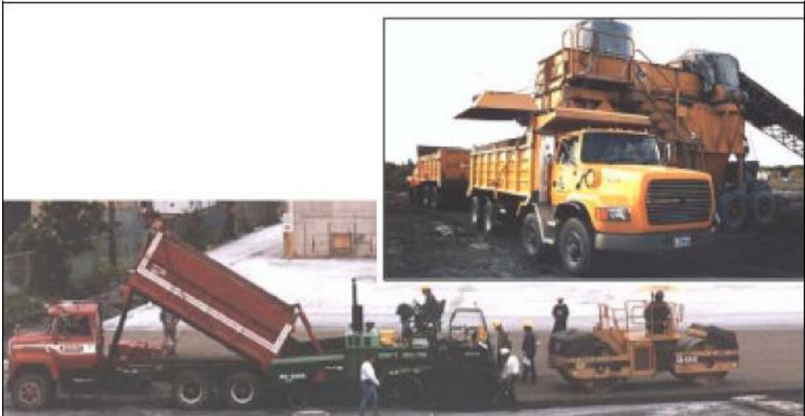
Fotoğraf 3.3. SSB'nin taşınması ve yerleştirilmesi
