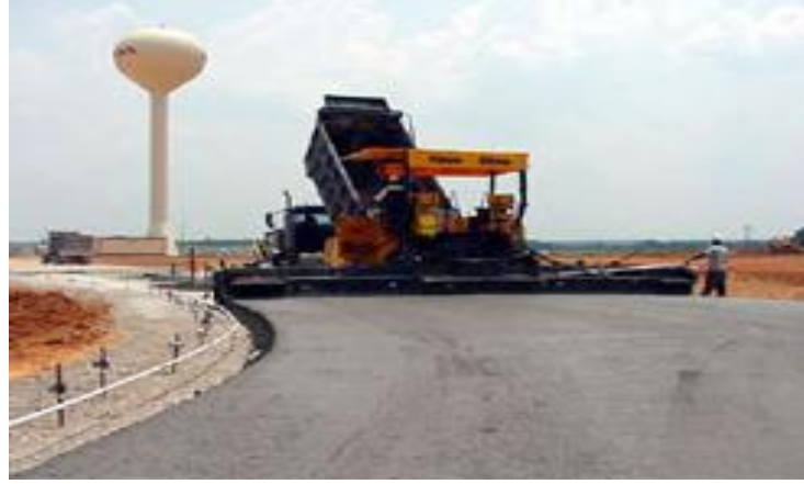
Fotoğraf 3.5. Rolkritin finiřerle zemine serilmesi (Topçu, 2006).
