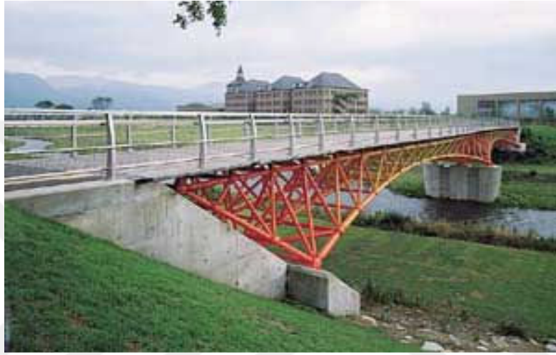
Fotoğraf 2.17. Uzay kafes taşıyıcı sistem kullanılmış bir karayolu köprüsü
