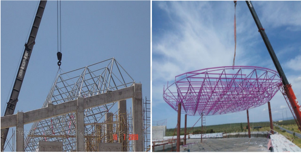
Fotoğraf 2.21. Yerde montajı yapılan sistemin vinçle yerine montajı
