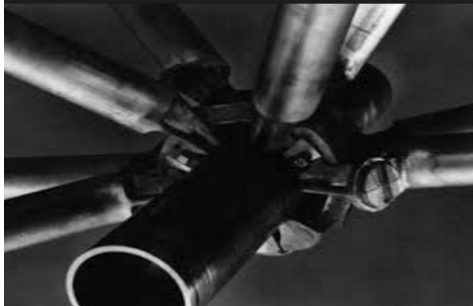
Fotoğraf 2.8. Wachsmann düğüm noktası
