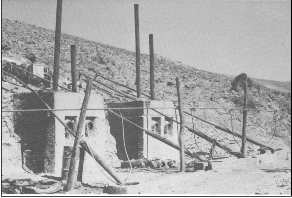
Şekil 5.2. 1966 yılından Gümüşler madeninden elle ayrılmış cevherlerden cıva toplamak için kullanılan tesislerden bir görünüm (Fotoğraf: Yıldız ve Bailey, 1978)
