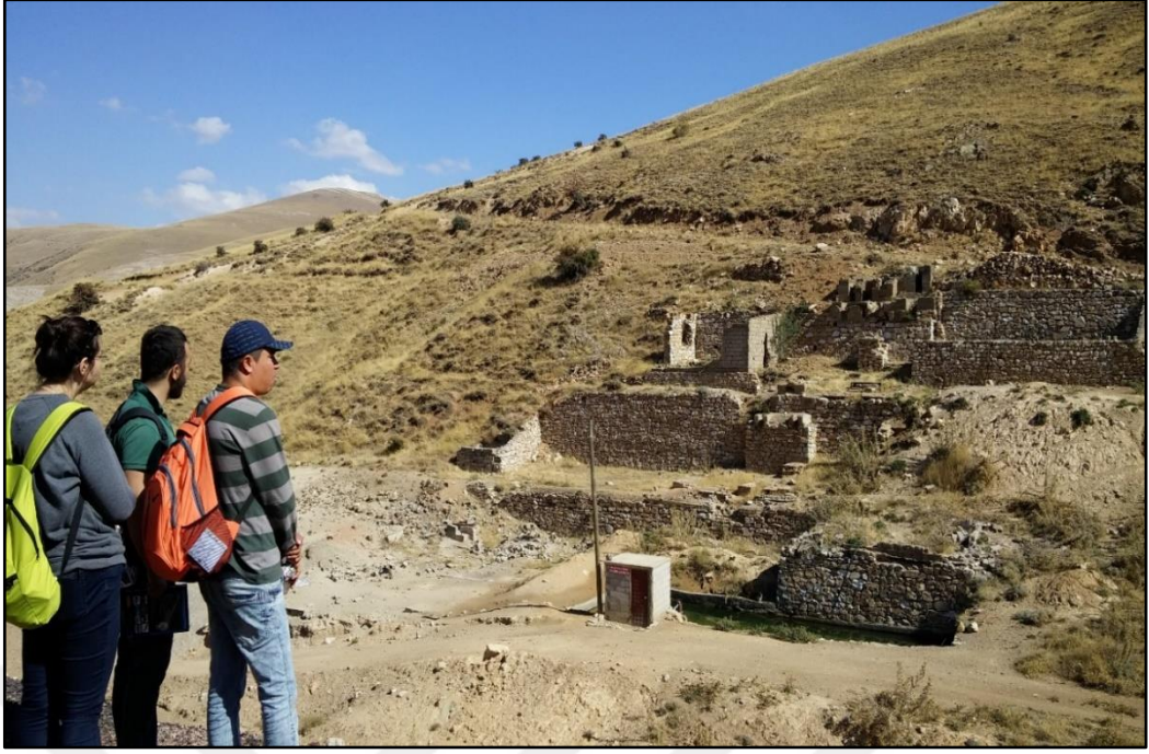
Fotoğraf 5.2. Gümüşler kasabası güneyinde yer alan eski cıva üretim tesisi genel görünümü
