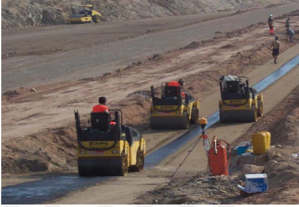
Fotoğraf 2.3. Asfalt çekirdekli baraj imalatı örneđi
