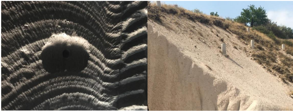
Fotoğraf 4.9. C deposu havalandırma bacaları
