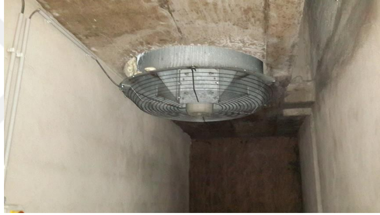
Fotoğraf 2.13. Kayadan oyma depolarda mekanik havalandırma
