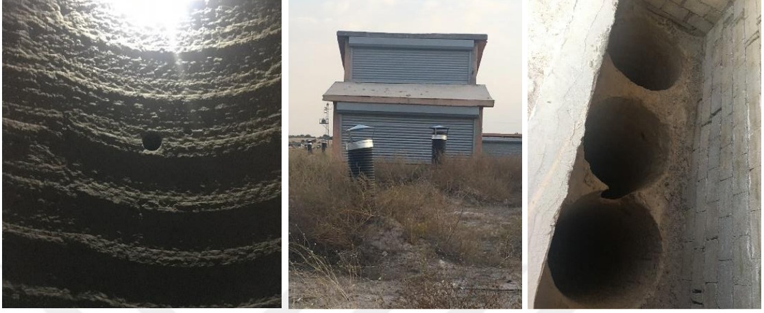
Fotoğraf 4.6. B deposu havalandırma bacaları
