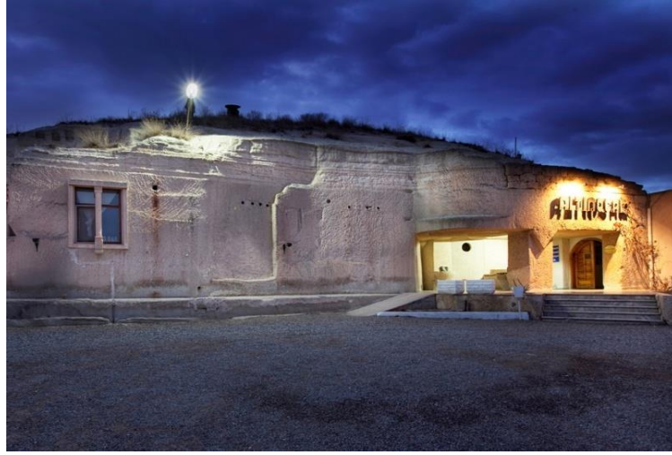
Fotoğraf 2.8. Kayadan oyma restoran giriş cephesi, Avanos
