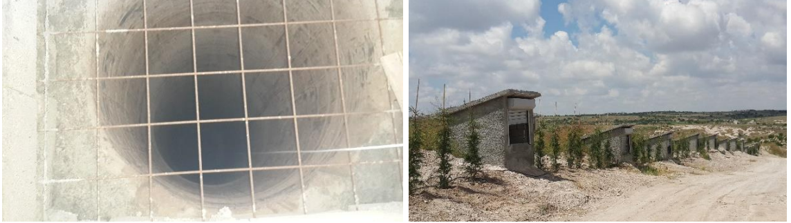
Fotoğraf 2.12. Kayadan oyma depolarda doğal havalandırma
