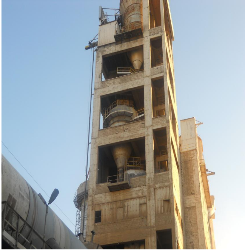
Fotoğraf 2.2. Ön Isıtıcı Sistemi (Niğde ÇİMSA).
