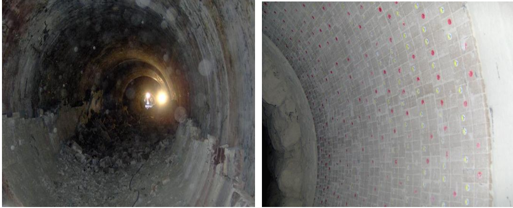
Fotoğraf 2.4. Döner fırında tuğla değişimi (Niğde ÇİMSA).
