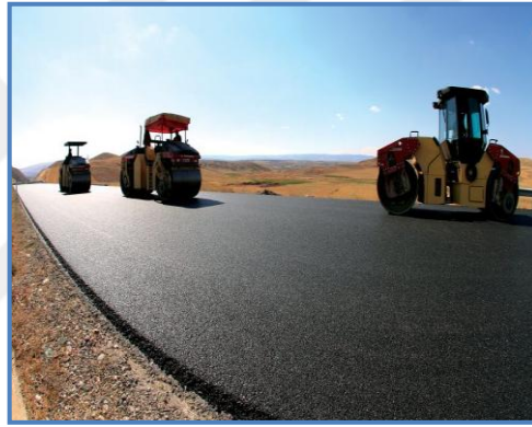
Fotoğraf 3.3. Bitüm ile stabilizasyon (URL-6, 2018)
