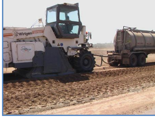
Fotoğraf 3.2. Çimento ile zemin stabilizasyonu (URL-5, 2018)
