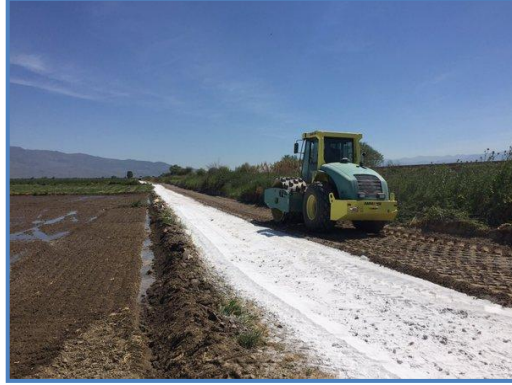
Fotoğraf 3.1. Kireçle zemin stabilizasyonu (URL-4, 2018)
