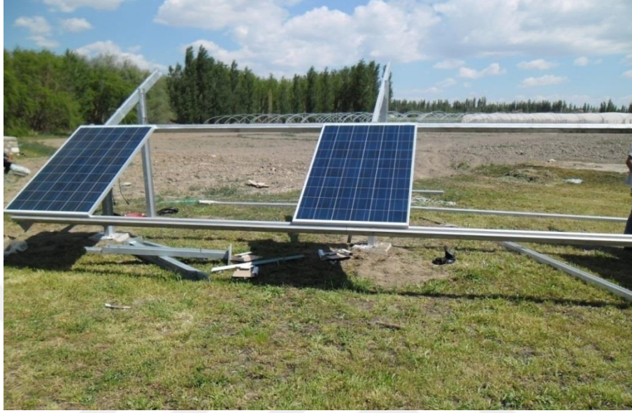
Fotoğraf 5.6. Fotovoltaik panellerin montajı
