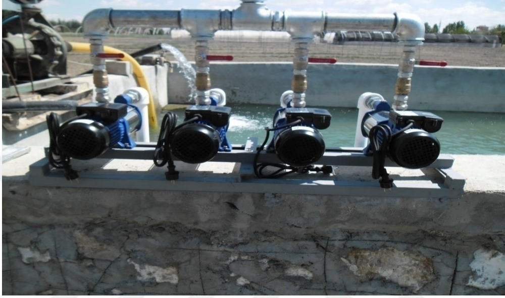
Fotoğraf 5.8. Pompaların havuzun üstüne montajı
