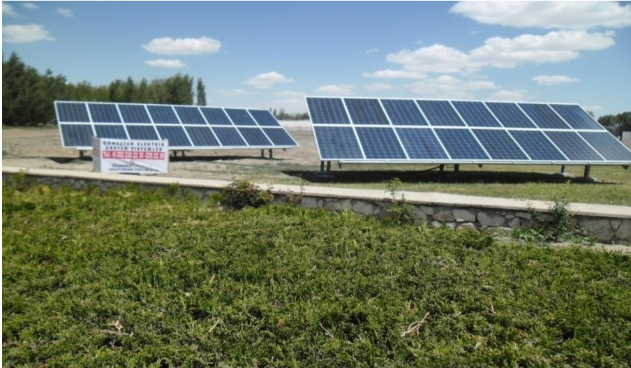
Fotoğraf 5.7. Montajı yapılan fotovoltaik paneller
