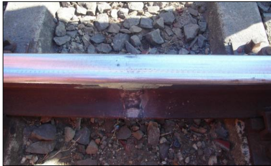
Fotoğraf 2.13. İnce taşlama görünümü (Koçtürk, 2014)
