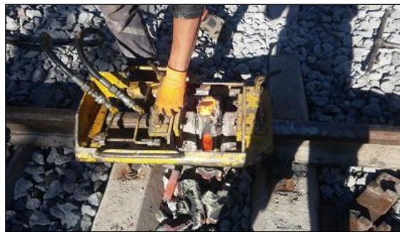
Fotoğraf 2.11. Kaynak fazlalığının sıyırılması
