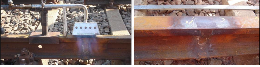
Fotoğraf 2.14. Perlitleme ve sonrası ray görünümü (Koçtürk, 2014)
