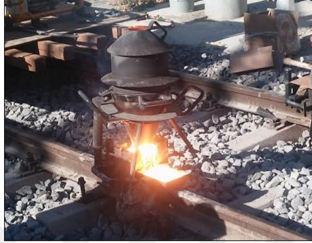
Fotoğraf 2.8. Döküm yapılması
