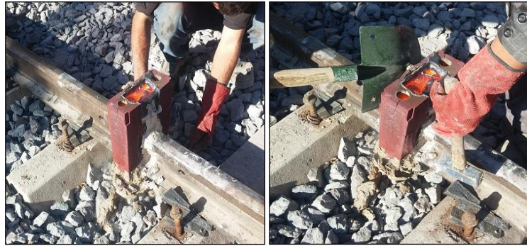
Fotoğraf 2.9. Kalıp tutucuların alınması Fotoğraf 2.10. Kalıbın alınması
